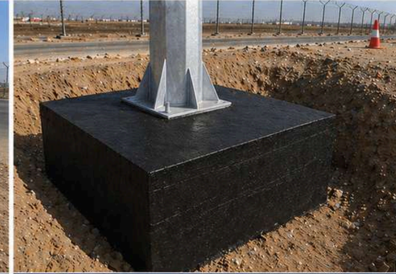
أعمال صب القواعد الخرسانية وتركيب الصفائح والقلووظ
