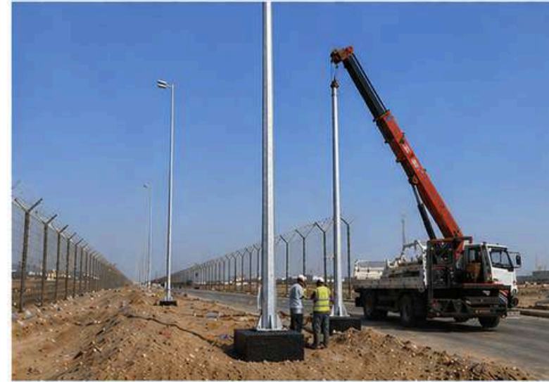
توريد وتركيب أعمدة الإضاءة وتثبيتها على القواعد
