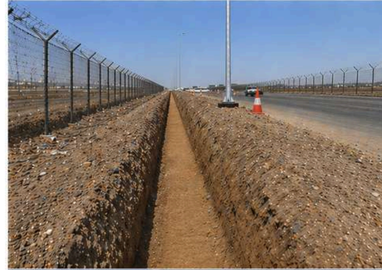
أعمال الحفر وتمديد مواسير الكابلات
