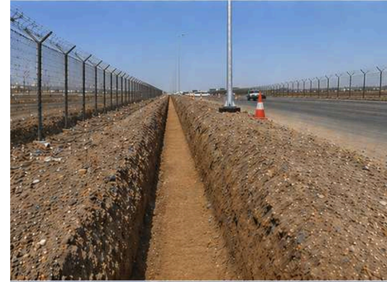
أعمال الحفر وتمديد مواسير الكابلات
