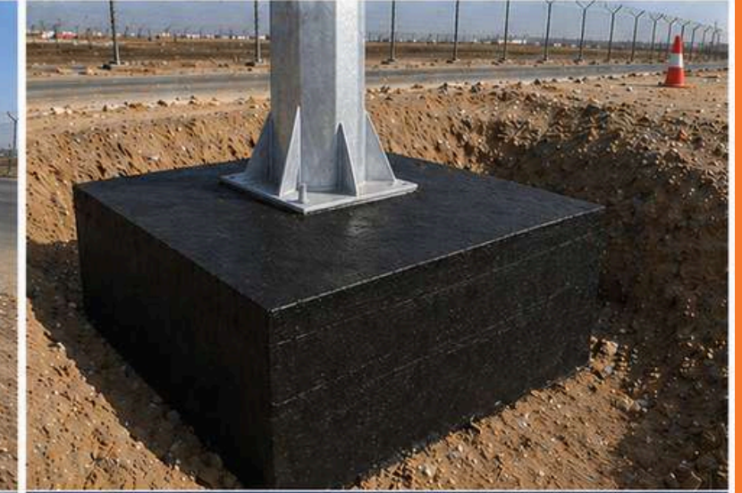
أعمال صب القواعد الخرسانية وتركيب الصفائح والقلووظ
